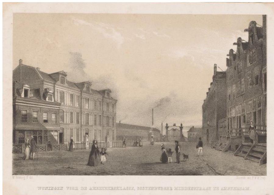
De Oostenburgermiddenstraat op Oostenburg met links de eerste woningen gebouwd door de Vereeniging ten behoeve der Arbeidersklasse te Amsterdam.
